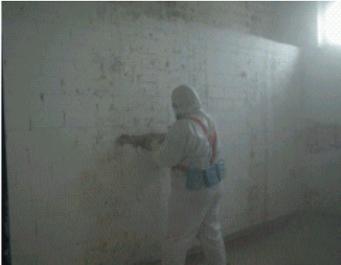
Bild 5: Beispiel für starke Sporenexposition (Gefährdungsklasse 3) beim Abschlagen von Putz ohne Absaugung
