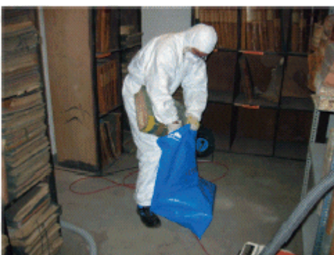
Bild 7: Beispiel für mittlere Sporenexposition (Gefährdungsklasse 1 oder 2, je nach Dauer der Tätigkeit) beim Verpacken von mit Schimmelpilzen kontaminiertem Archivgut, das zuvor oberflächlich abgesaugt wurde
